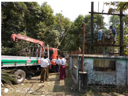
Renovation des Generators
