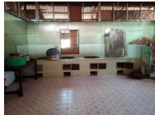
Die Küche ist auch 3 Jahre nach dem Bau immer noch in gutem Zustand
