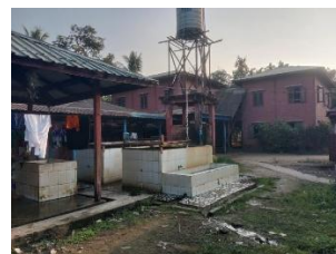
Der Wasserturm und die Waschplätze
